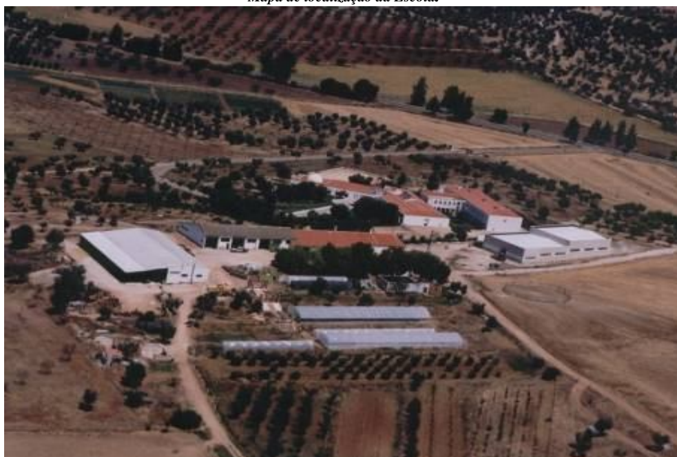
Vista geral da escola.
